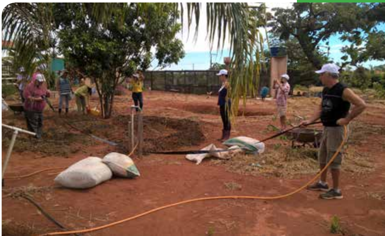
Figura 11 – Hora de colocar a mangueira Santeno. *Cuidar para os furinhos ficarem para cima
