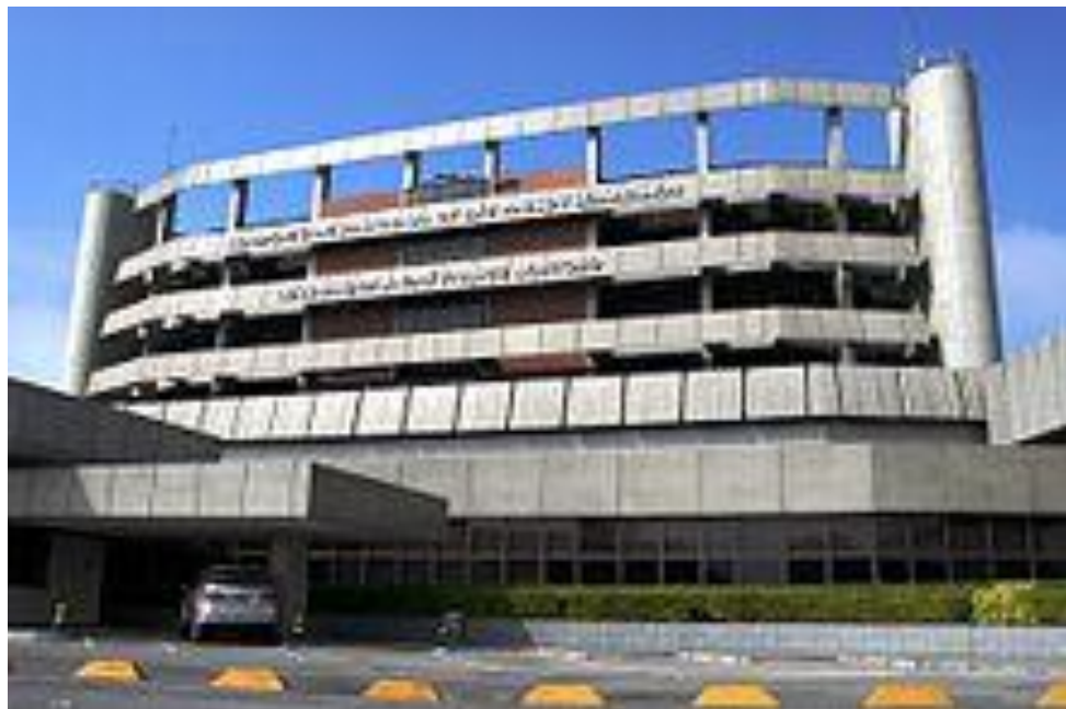
Fachada do aeroporto.
